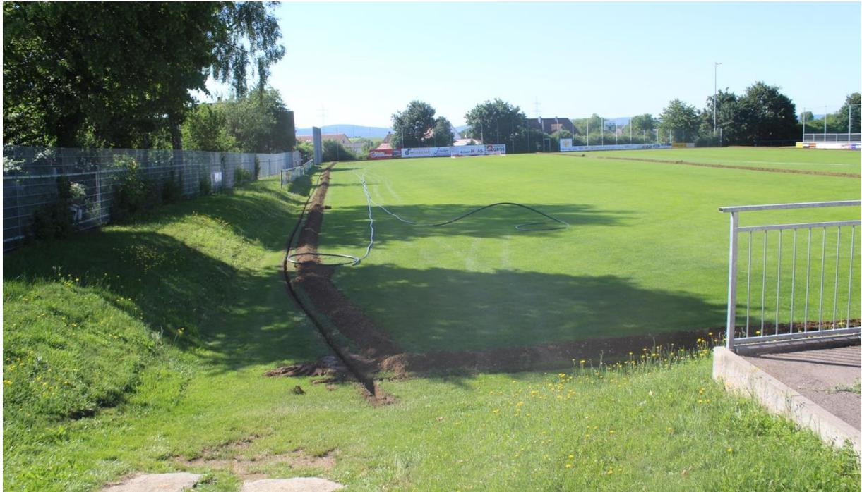
Hierzu wurden entlang der Außenlinie und Grundlinien ein ca. 10cm breiter und ca. 40 cm tiefer Graben mit Spezialmaschinen heraus gefräst.
