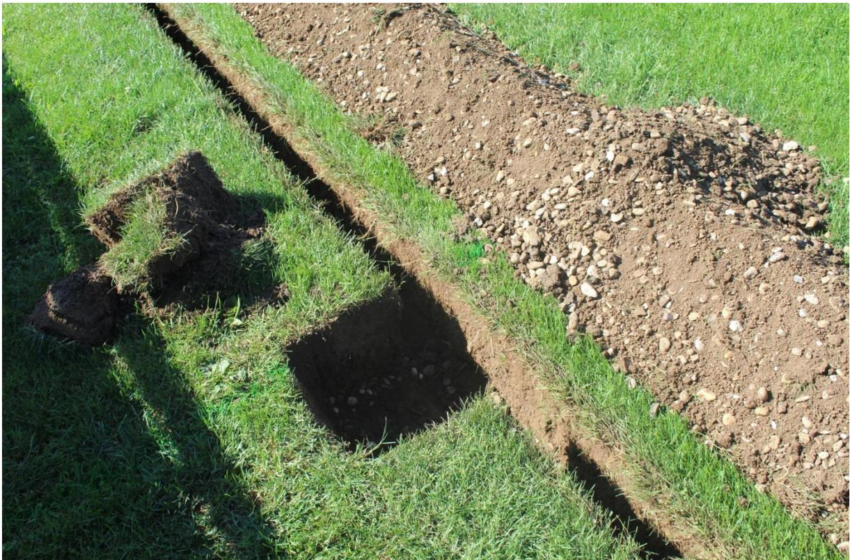
Kurz danach wurde das Bewässerungsrohr sowie die notwendigen Steuerkabel verlegt und die Beregnungsschächte eingebaut.
